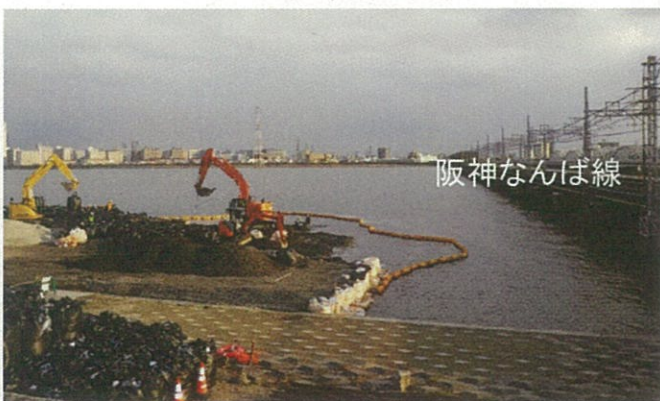
高水敷造成状況
