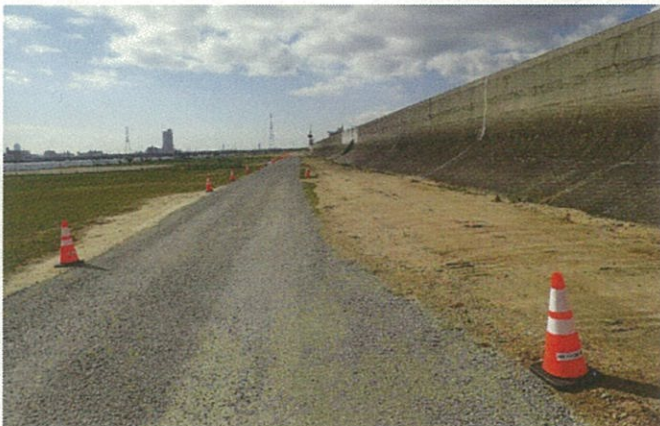
工所用道路整備
